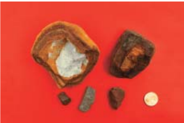
Abb. 23: Oxidische Eisenverbindungen verursachen Schäden insbesondere bei Sichtbeton.
