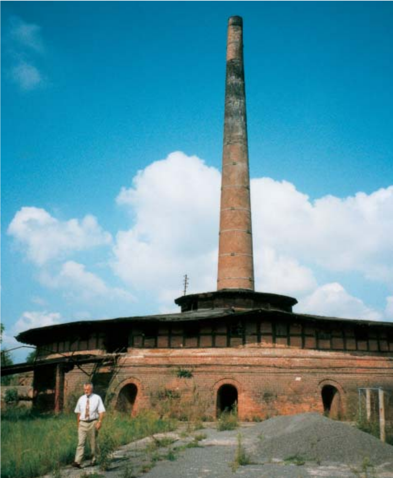
Abb. 8: Ringofen der ehemaligen Ziegelei Pary (Zustand 1997). Einziger in Sachsen-Anhalt noch erhaltener kreisrunder Hoffmann'scher Ringofen mit mittigem Schornstein.
