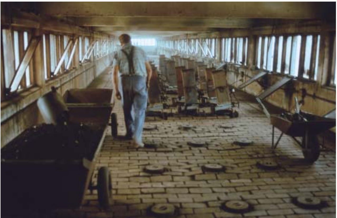
Abb. 7: Arbeitsbedingungen in einer früheren Ziegelei. Ofendecke eines Tunnelofens (Nachfolger des Ringofens) mit Schürapparaten für Braunkohlengrus-Befuerung. Im Vordergrund Schürlochdeckel („Brennlöcher“). Ziegelei Gröningen um 1985.
