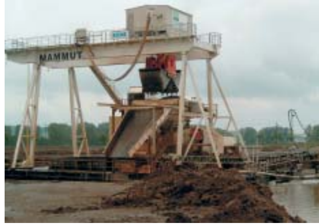
Abb. 37: Der Nassabbau IV-1 erfolgt mit einem Schwimmgreifer. Im Bild erkennbar, der gerade hoch gezogene, mit Kiessand gefüllte Greifer, aus dem das Restwasser abfließt. Zur Entleerung des Fördergreifers wird der Greifer nach rechts über den Aufgabetrichter gefahren.
