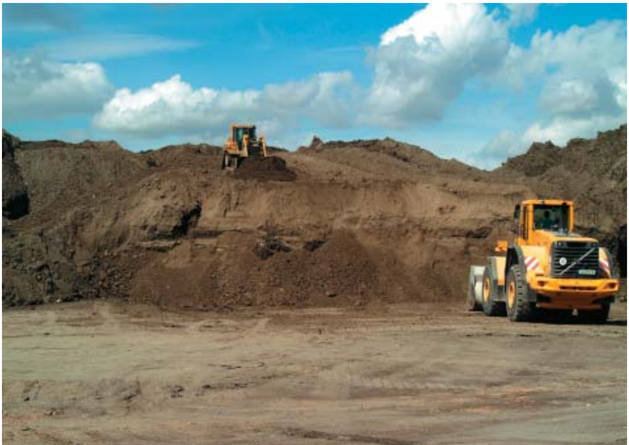
Abb. 1: Bereitstellung von Dammbaustoff für den Hochwasserschutz an der Elbe. Die Oligozäntone im Leitzkauer Stauchfaltenkomplex östlich von Gommern sind als gut barrierewirksam eingestuft.
