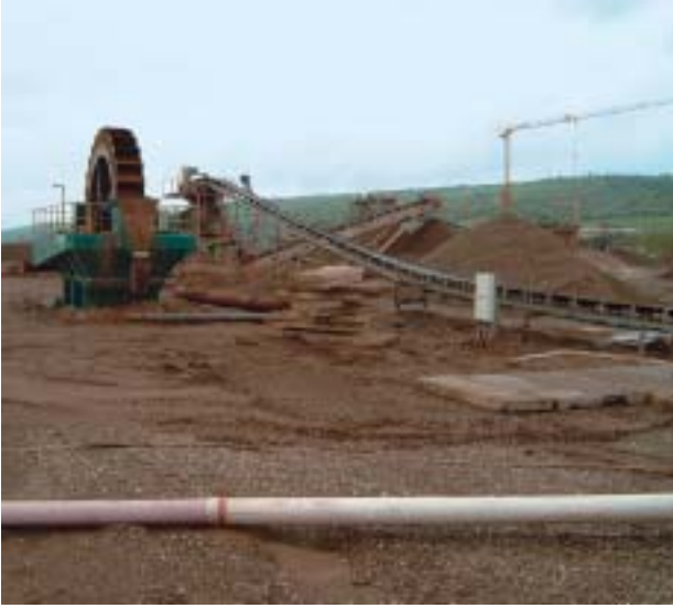
Abb. 41: Gewinnungsstelle IV-4. Blick auf die Aufbereitung des Rohkieses (hier Waschrad). Rechts daneben Rohkiesförderband mit anschließendem Aufgabetrichter und Fertigprodukthalden.
