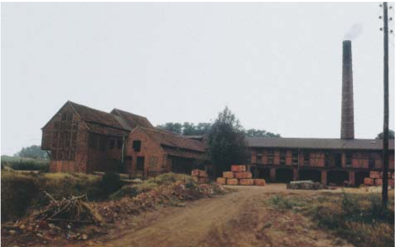
Abb. 20: Die Ziegelei Westeregeln in Produktion (ca. 1985). Unter dem Schornstein im Gebäude ein Oblonger Ringofen (Baujahr 1890, erweitert 1936) mit Fachwerk-Ofenaufbauten und Trocknung über dem Ofen. Links die Trockenscheune, davor die Rampe in den Tagebau. Die Ziegelei ist baulich und technisch vollständig funktionsfähig und heute als Ziegelei- und Gipshüttenmuseum zu besichtigen.
