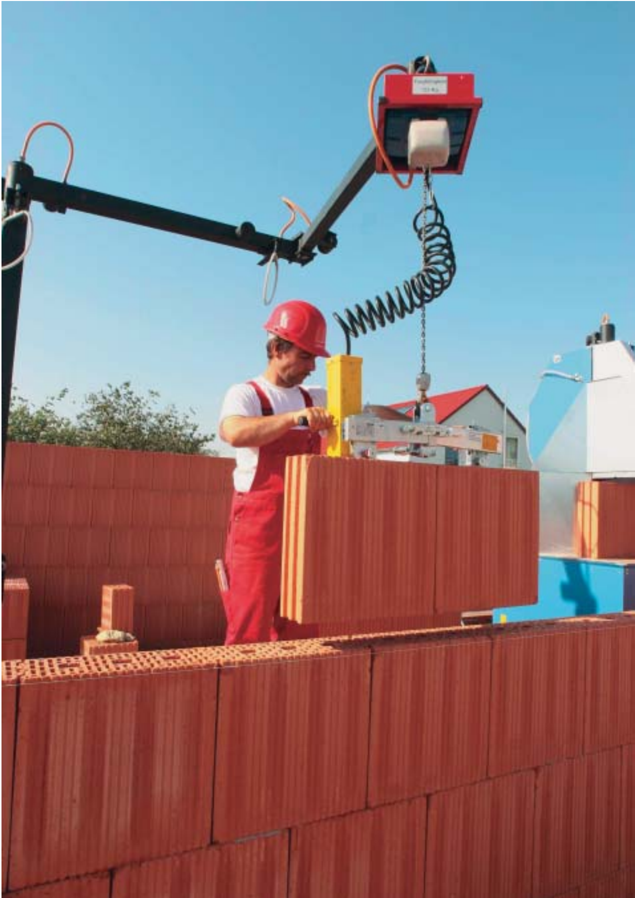
Herstellung von modernem Ziegelmauerwerk.
