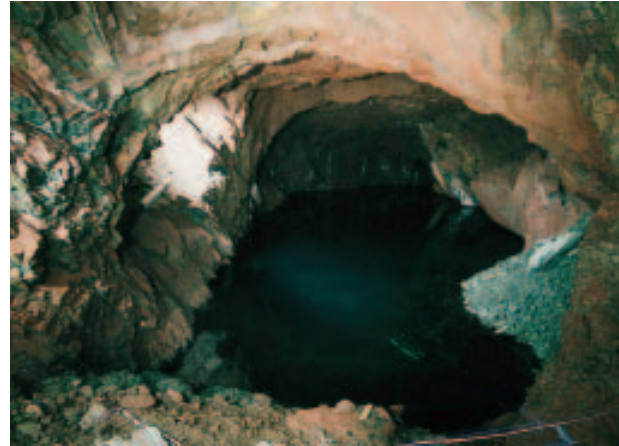
Abb. 15: Blick in einen alten Abbau des Holzberglagers auf der 5. Sohle in der Grube Braunesumpf bei Hüttenrode.
