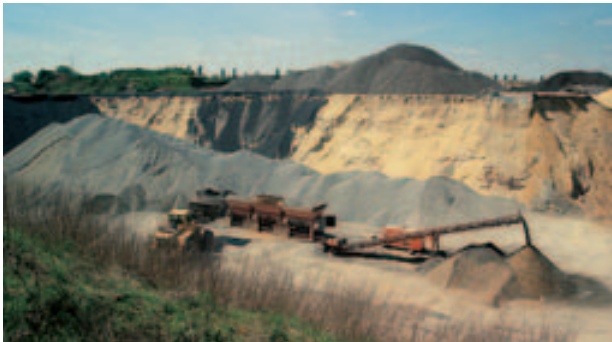
Abb. 10: Sandtagebau Klieken-Nord mit rezykliertem Asphalt-Sträßenaufbruch. In dieser Gewinnungsstelle werden aus gesiebten Natursanden der Lagerstätte und Aufbruchmassen Mineralgemische für den Straßenbau hergestellt.
