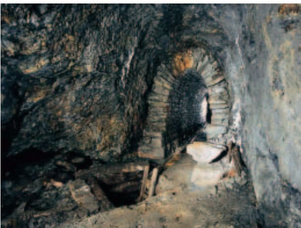
Abb. 14: Im Altbergbau der Grube Büchenberg. Derartige Strecken wurden in der Mitte des 19. Jahrhunderts zum planmäßigen Aufschluss der Eisenerze aufgeföhren. Sie ermöglichten eine deutliche Produktionssteigerung (Foto J. KRUSE, Elbingerode).
