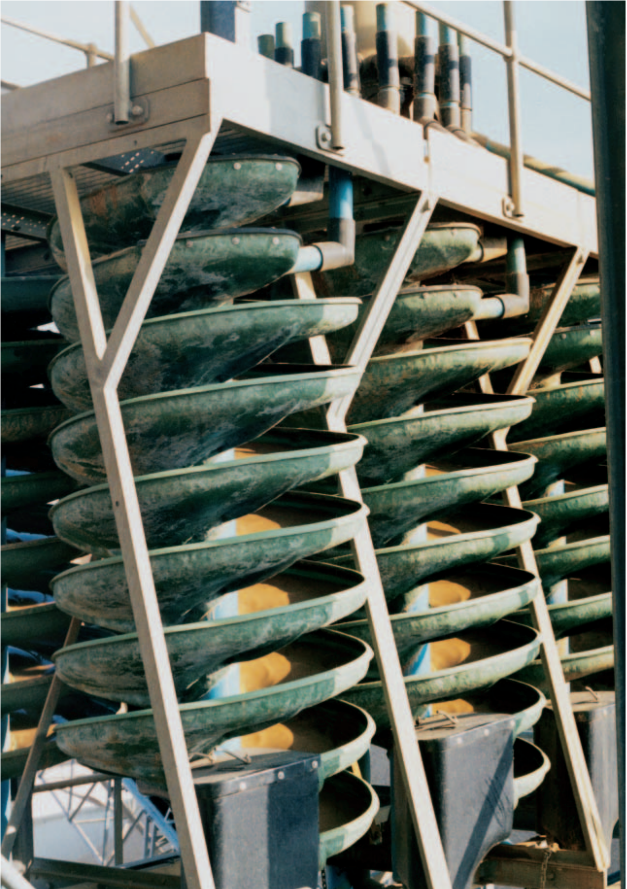
Entkohlung der Feinsandfraktion (Kieswerk Löberitz bei Bitterfeld)
