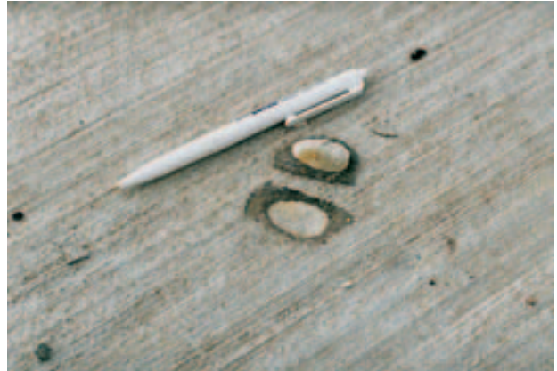
Abb. 1: Zuschlagbedingter Betonschaden im Kappenbereich einer Autobahnbrücke (BAB 14) nördlich Halle. Deutlich zu erkennen ist eine Abplattung (so genannter „popout“), die durch ein oberflächennahes Kreide-Kieskorn verursacht wurde.
