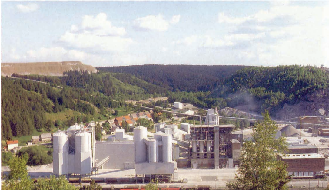
Abb. 5: Beispiel für eine umfassende Modernisierung aller betrieblichen Prozesse, sparsamem Umgang mit der Lagerstättensubstanz (Haldenrückgewinnung) und Einsatz moderner Umwelttechnologien sind die Kalksteintagebaue des Elbingeröder Komplexes im Mittelharz. Hier die Kalksteinaufbreitung mit Waschanlage, Brennbetrieb mit Schotter- und Kleinsteinoefen, Mahl- und Grießeanlage sowie Silo- und Verladeeinrichtungen. Im Hintergrund die Unterkornhalde „Kleines Tiefbachtal“. Hier erfolgt Haldenrückbau. (Mit freundlicher Genehmigung der FELS-WERKE GmbH, Goslar).
