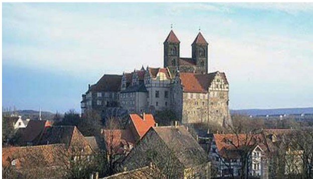
Abb. 1: Schlossberg Quedlinburg, Aufnahme vom Münzenberg (NW) Quelle: Internetseiten der Region Braunschweig-Ostfalen).
