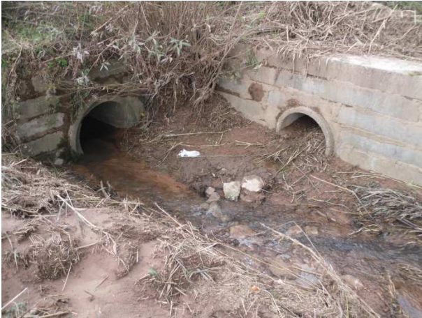
Abb. 12: Zu schmale und verstopfte Grabendurchlässe in Riestedt (Foto: H. Helbig). Fotostandort 2 (vgl. Abb. 5)
