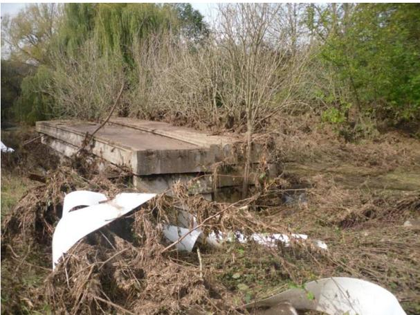
Foto 12: Abflussbehinderung durch „vergessene“ Betonelemente im Talquerschnitt westlich des Bründelschen Dorfteiches.
