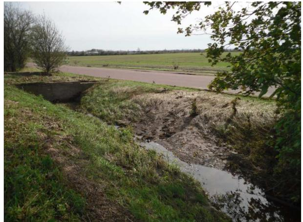
Foto 15: Der sonst ruhige Münzbach bei Bründel hatte sich am 11.09.11 zu einem Sturzbach entwickelt, staute sich vor diesem Rohrdurchlass an der Straße von Bründel nach Plötzkau, brach aus seinem Bett aus und floss auf der anderen Straßenseite weiter Richtung A 14 zur Übertrittsstelle Nr. 4.
