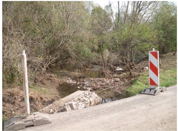
Foto 14: Zerstörung eines Durchlasses durch Starkregenabfluss westlich des Bründelschen Dorfteiches. Ursache: Starkregen und Abflussbehinderung (siehe Bilder oberhalb).
