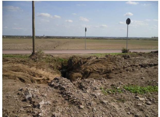
Foto 4: Durch Erosion teilweise ausgespülter Durchlass unter der Landesstraße L 74 (Alsleben-Bründel), südlich der Ortschaft Bründel. Davor Ablagerung von erodiertem Boden und Steinen. Blickrichtung Ost, im Hintergrund die A 14.
