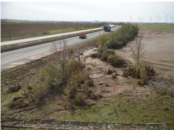
Foto 19: Übertrittsstelle Nr. 4 und unmittelbar vorgelegerte Sedimentationsstelle. Ein Übertritt auf die A 14 war gegeben, aber ein Teil des Wassers ist auch unter der Autobahnbrücke Richtung Norden in den Münzbach geflossen.
