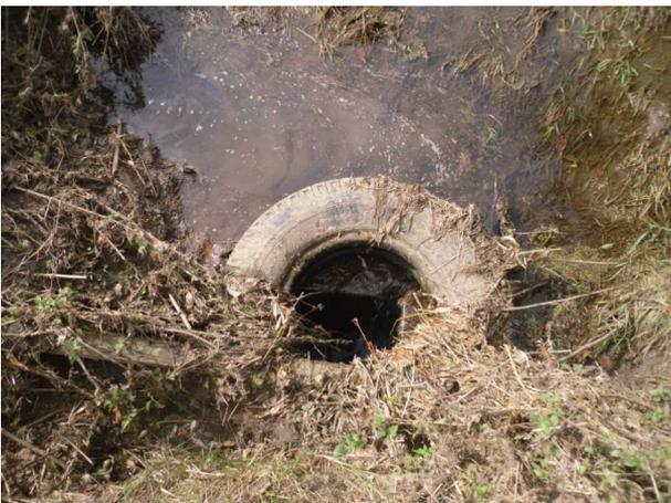
Foto 13: Abflussbehinderung an einem betongefasstem Schluckloch westlich des Bründelschen Dorfteiches, das als Durchlass unter einer Straße fungiert. Im Normalfall ausreichend, bei Starkregen viel zu schmal.
