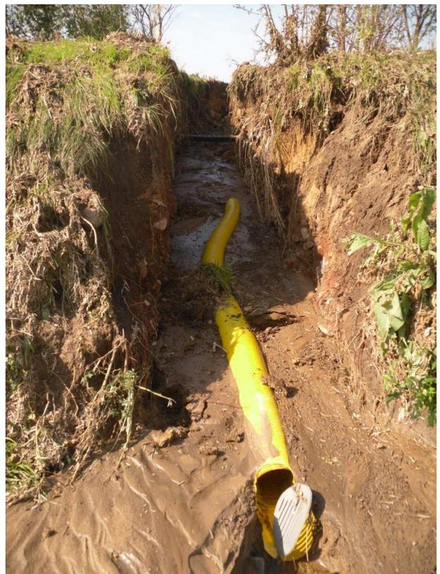
Foto 21: Ausgespülte Drainageleitung an Übertrittsstelle Nr. 3. Diese Drainageleitung entwässerte unmittelbar in den Straßengraben der A 14.
