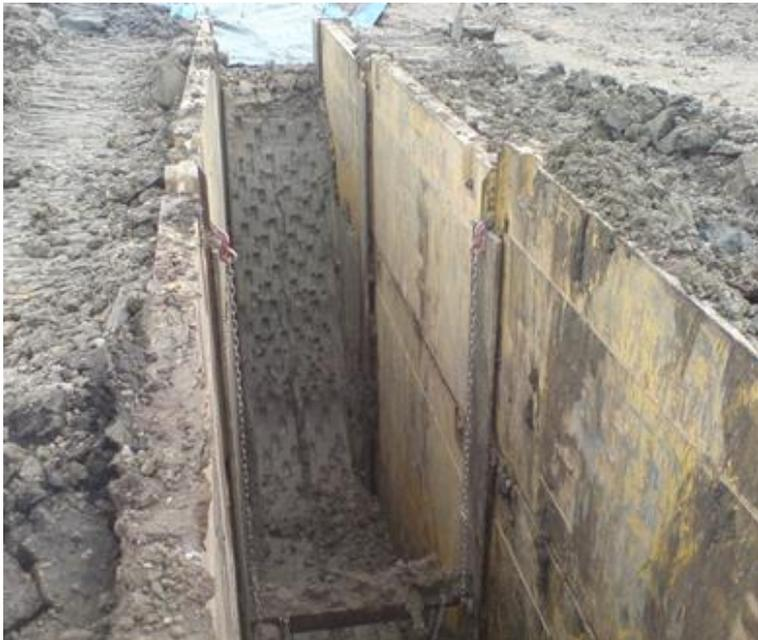
Errichtung Dichtwand im westlichen, südlichen und östlichen Randbereich des Abfallkörpers durch lageweisen Einbau des Blautones mit einem  $k_f$ -Wert  $< 1 \times 10^{-10}$
