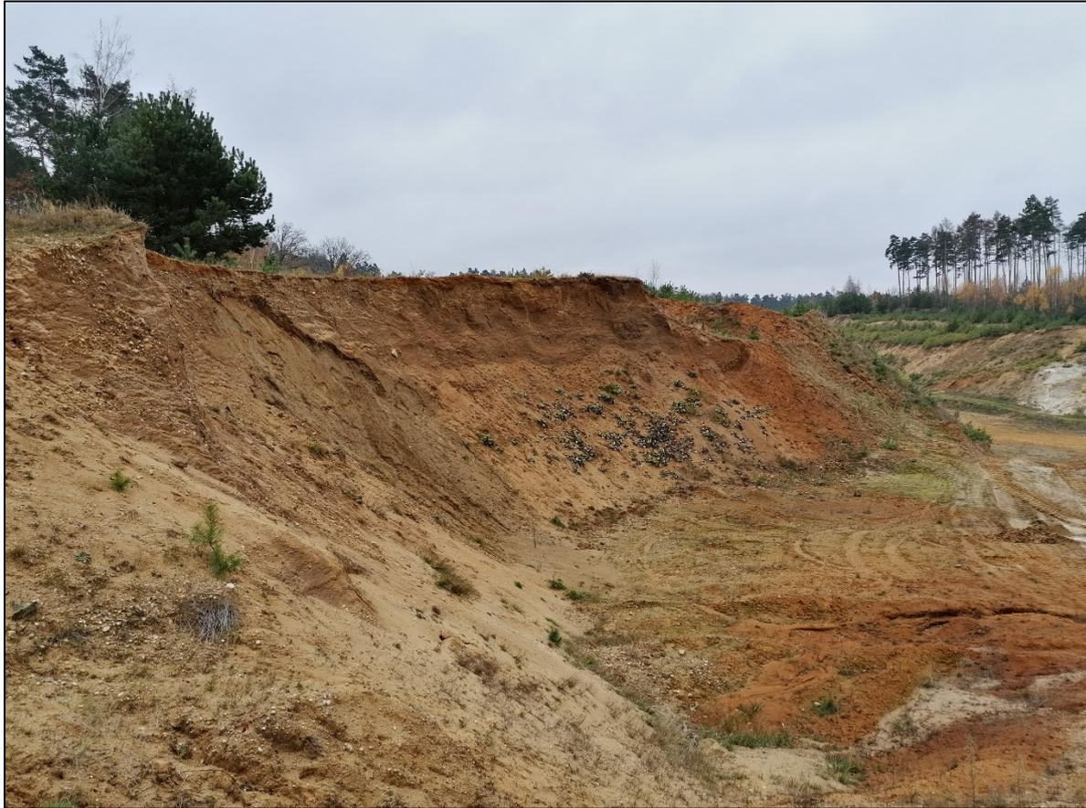
Blick nach Süden auf Ostböschung mit steilstehendem Geschiebemergel im oberen Böschungsbereich
