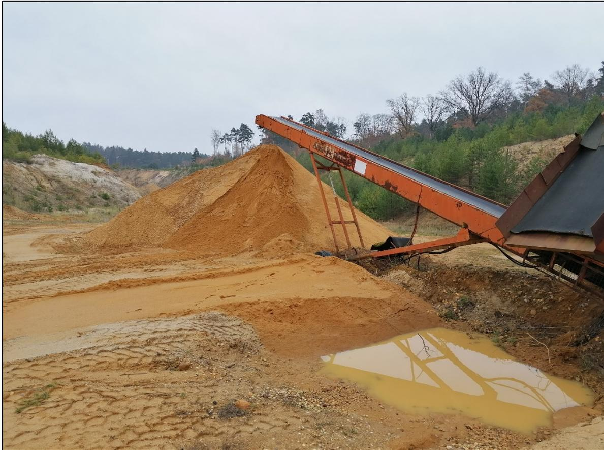
Baufeld III Haufwerk Sand kiesig 0/16 nach Siebung Schüttwinkel ca. 38° lockerste Lagerung
