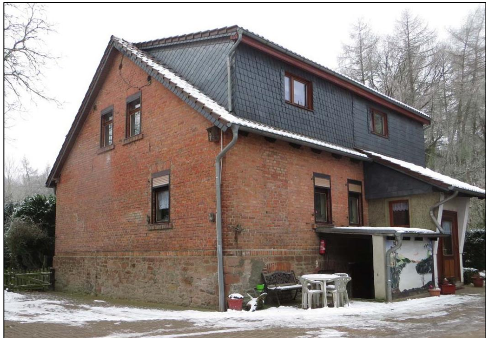
Abb. 2 Objekt H, Wohnhaus 1
