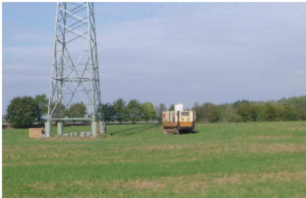
Abb.1: 09.09.2020, Drucksondierung CPT-1, links im Bild: Mast Nr. 67
