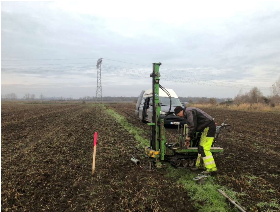
Abbildung 6: Erkundungsarbeiten am Aufschlusspunkt RKS 1
