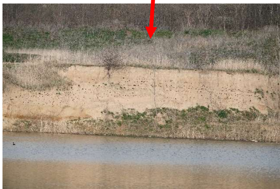
Abbruchkante am Ostufer mit Bruthöhlen der Uferschwalbe
