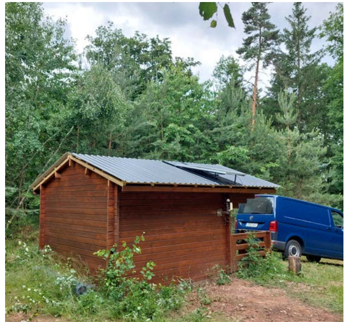
Abb. 3.2-3: Stationshütte der Messstelle TH.BADSA „Bad Salzungen“ (Foto: D. Schönwald).
