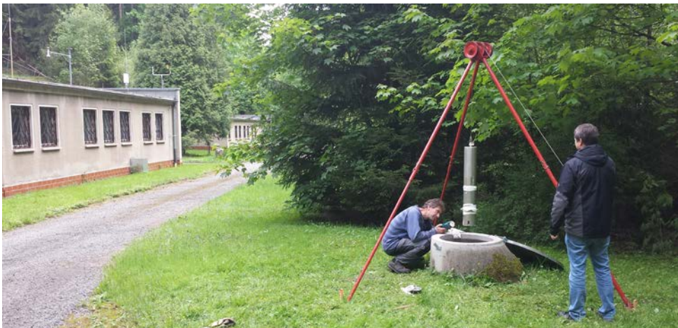
Abb. 3.2-7: Station MOXB auf dem Gelände des geodynamischen Observatoriums Moxa beim Einbau des Bohrlochseismometers (Foto: D. Schönwald).
